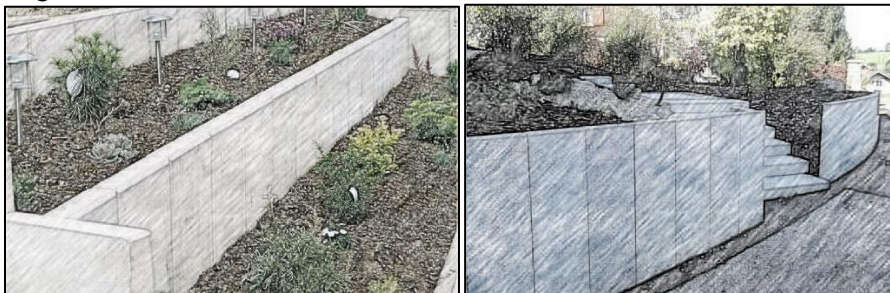
Exemples de soutènements béton
