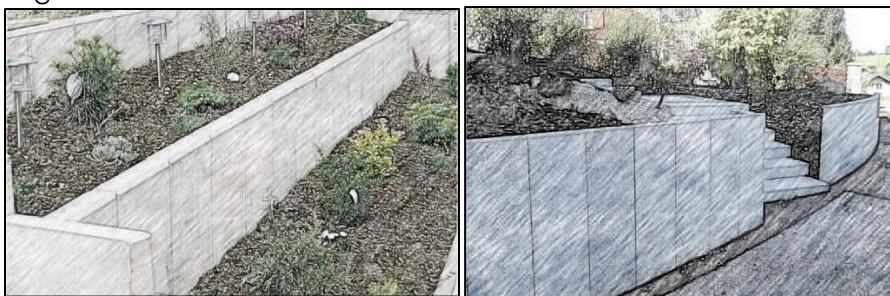
Exemples de soutènements béton
